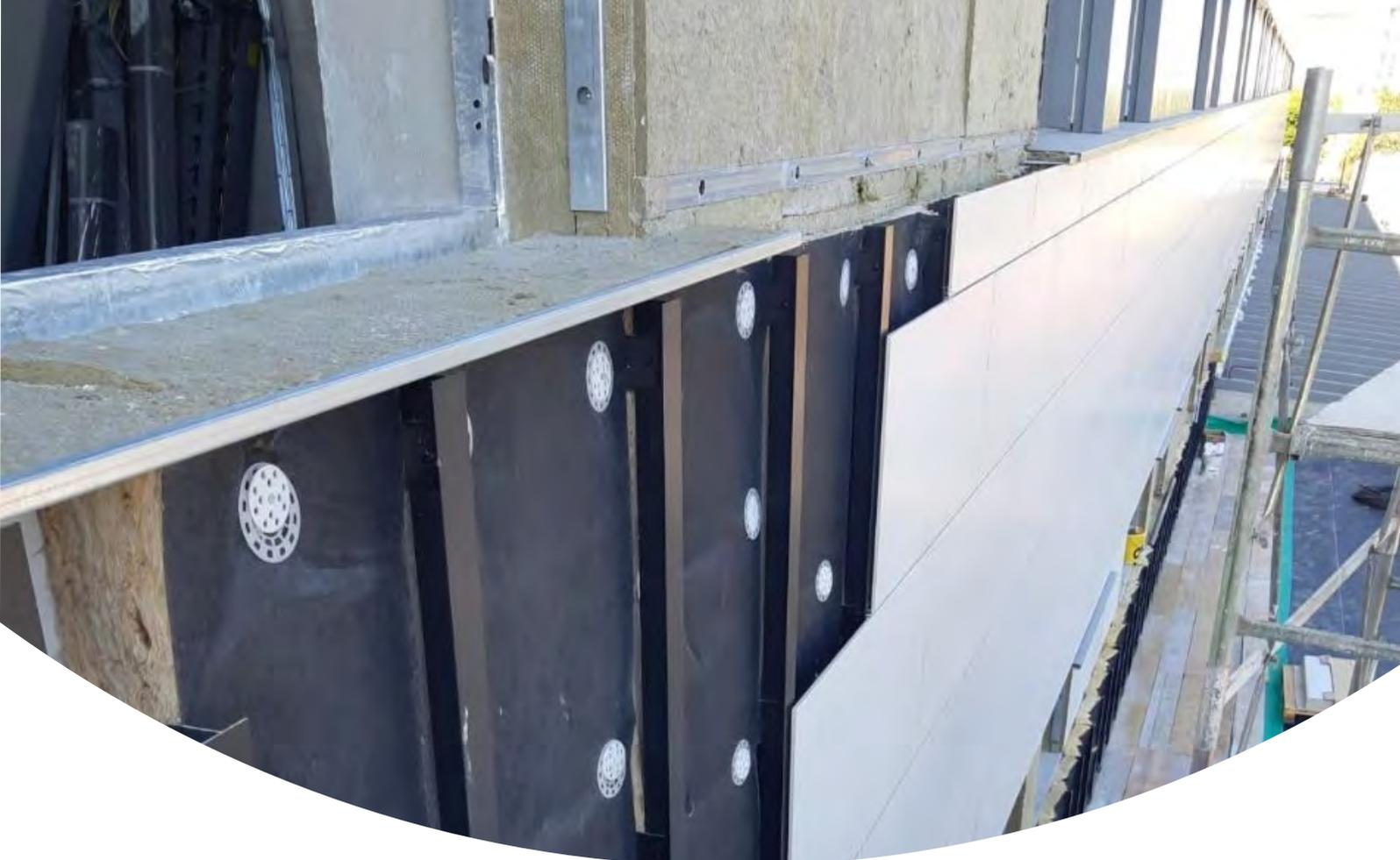
Fasi di posa e di fissaggio dell'isolante in facciata.
